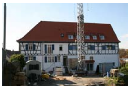
Im Garten des Hofguts (im Bild die Ostansicht) entstehen die Reihenhäuser.
