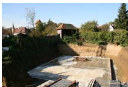
Fast täglich ist der Fortschritt der Neubauten zu sehen.
