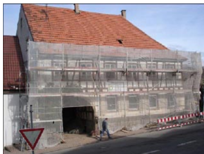
20. März 2008, der Bau hat begonnen
